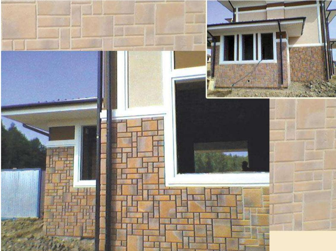
При укладке рекомендуется руководствоваться обычным правилом - сокращением длины вертикальных швов. Укладывать плитку следует только **со швом 1см**. Плитка, уложенная таким образом, создает красивый визуальный эффект. Кроме того, размеры разных плиток рассчитаны так, что только со швом 1см будет соблюдаться необходимая при укладке кратность размеров и взаимозаменяемость фрагментов кладки.
