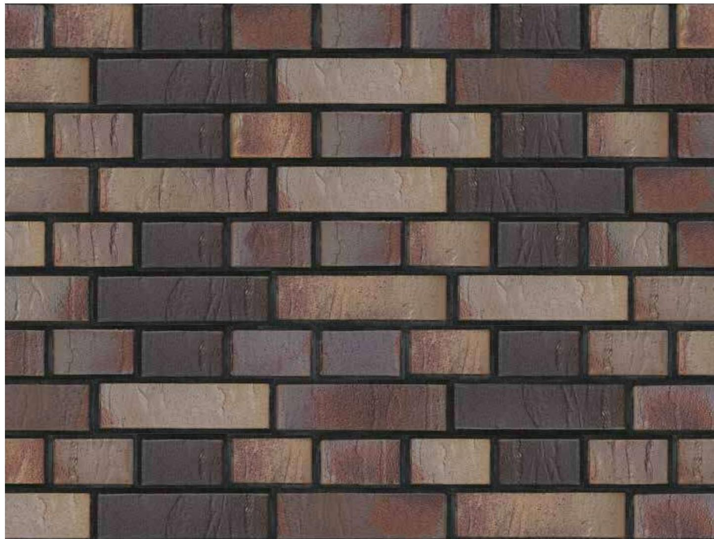
ЛОЖКОВАЯ СХЕМА КЛАДКИ: смещение на 1/2 кирпича
